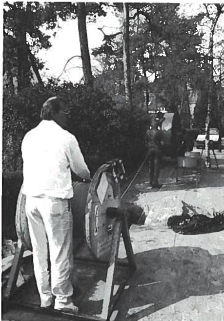
Afb. 2. Het opspoelen van glasvezelkabel op de „van den Akker haspel”.
